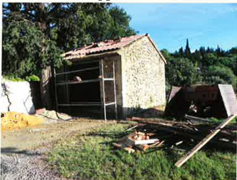
Rénovation de l'appentis du cimetière.
