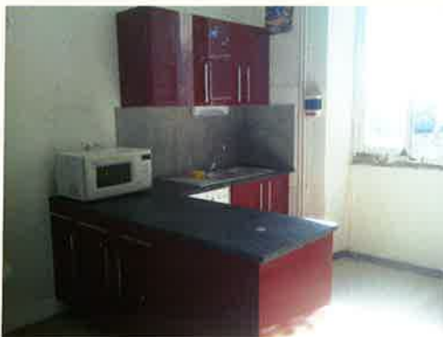
Rénovation coin cuisine de Pécole
